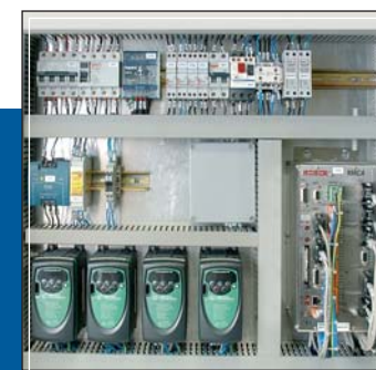
Cuadro eléctrico Electrical panel Panneau électrique
