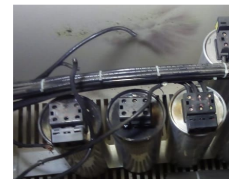
Falla en Condensadores
