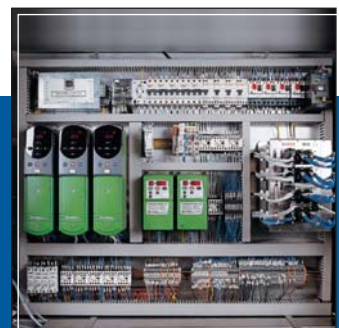
Cuadro eléctrico Electrical panel Panneau électrique
